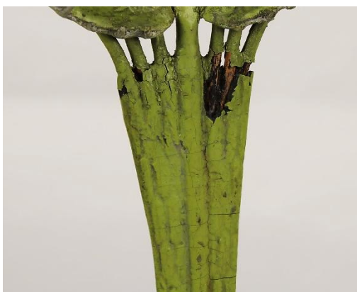
Fig. 52 Depositi superficiali in corrispondenza del motivo in rilievo.
