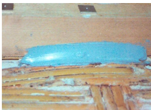
Fig. 75 “Molla” deformabile puntuale di collegamento tra centina e canniccio realizzata con resina epossipoliuretanica. Fotografia tratta da Quaglierini, D’Orazio, 2005, p. 119.
