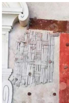
Fig. 59 Porzioni di canniccio rimasti intatti malgrado l'incendio posizionati sulla parete della galleria est. (Tratto da Orsero, 2020/2021, p. 123.)
