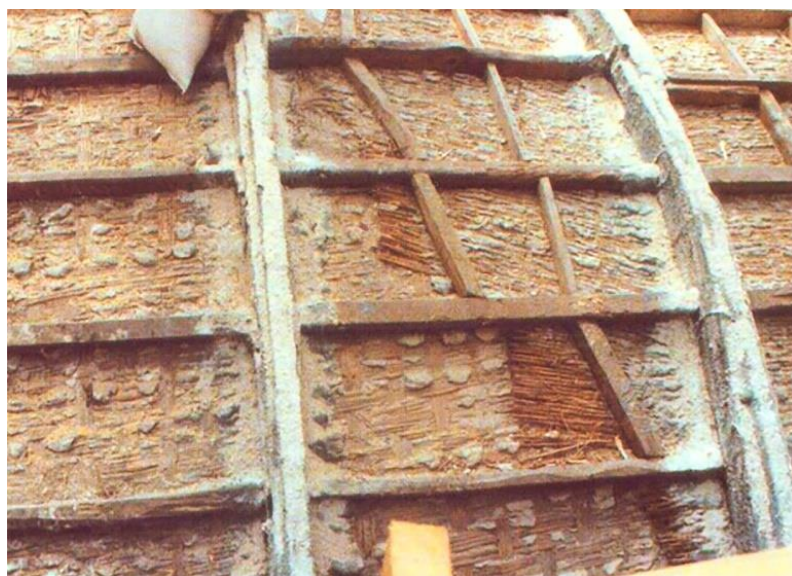
Fig. 77 Ripristino del canniccio ammalorato o in presenza di lacune con l'inserimento di una nuova stuoia di canne. Fotografia tratta da Quagliarini, D'Orazio, 2005, p. 93.
