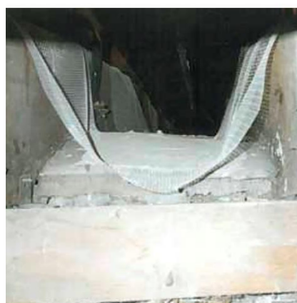
Fig. 71 Consolidamento con fibra di vetro e resina epossidica dell'estradosso del Teatro di Pieve di Cento. Fotografia tratta da Brunetti, 2016, p. 317.
