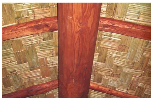
Fig. 19 Cannizzata con canne intrecciate per coperture. (fotografia tratta da Toni, 2012, p. 76.)
