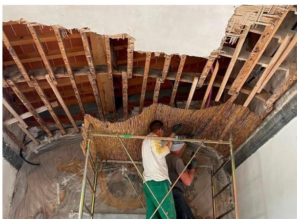
Fig. 89 Integrazione di un soffitto con stuoia prefabbricata all'interno del Complesso conventuale e Conservatorio di S. Niccolò a Prato. Lavoro eseguita dallo studio COMES.
