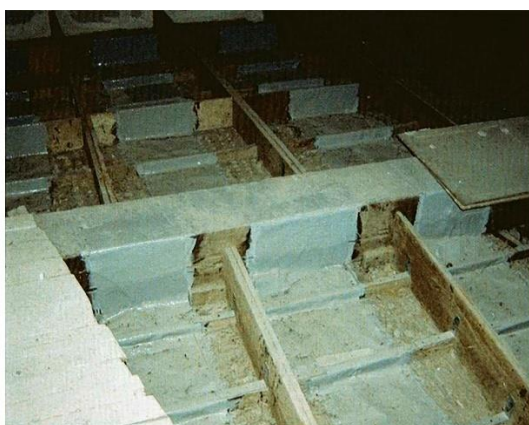
Fig. 70 Consolidamento con fasce di FRP e resina epossidica. Fotografia tratta da Fabbri, Analisi numerica di volte in camorcanna e gesso rinforzate con materiale FRP , 2009/2010, p. 23.
