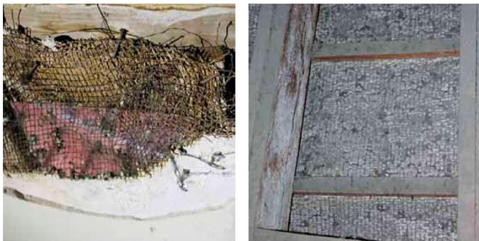
Fig 78-79 Uso delle rete metallica come supporto per il plafone del Teatro di Mirandola. Fotografia tratte da Brunetti, 2016, p. 242.
