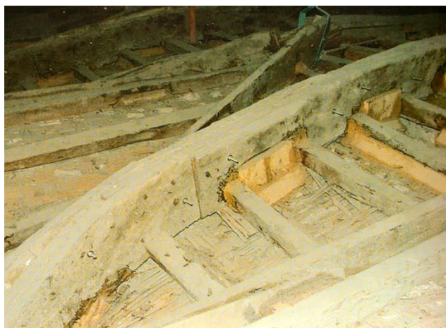
Fig. 72 Aggancio centina e stuoiato mediante blocchi di legno e resina epossidica. Fotografia tratta da Quagliarini, D'Orazio, 2005, p. 90.
