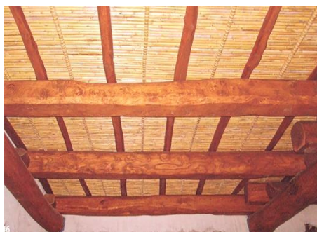
Fig. 18 Cannizzata con canne accostate per coperture. (fotografia tratta da Toni, 2012, p. 76.)
