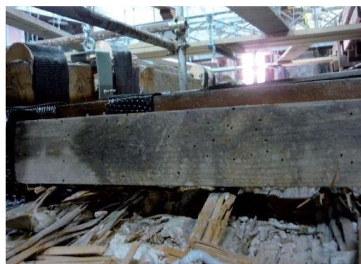
Fig. 67 Distacco tra centina e stuoiato. Tratta da Restauro di volte in cannucciato e volte leggere con affreschi e stucchi , AhRCOS S.r.l., Ancona.
