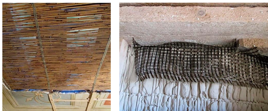
Fig. 86-87 Restauro del soffitto decorato di Villa Pullè a Verona. Ripristino stuoia crollata e applicazione di una rete FRP sulla superficie estradossale (foto del web).
