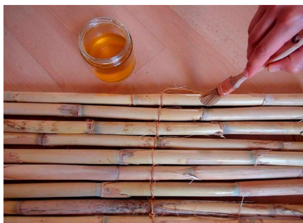
Fig. 90 Trattamento protettivo delle canne palustri.
