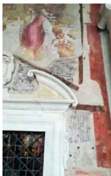
Fig. 59 Porzioni di canniccio rimasti intatti malgrado l'incendio posizionati sulla parete della galleria est. (Tratto da Orsero, 2020/2021, p. 123.)
