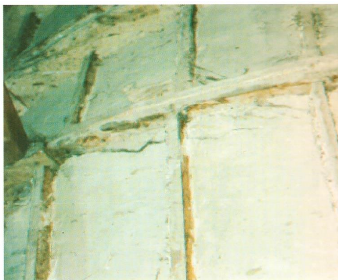
Fig. 69 Intervento con fasciature di tela di juta e gesso su superficie estradosale di una volta. Fotografia tratta da Quagliarini, D'Orazio, 2005, p. 94.
