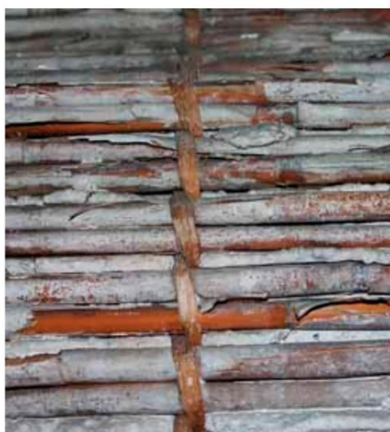
Fig. 37 Teatro di Crevalcore. Un arellata della volta legata con giunco palustre. Tratta da Brunetti, 2016, p. 239.
