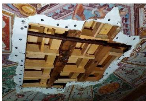
Fig. 135 Lacuna centrale rinfittita con assi di legno.
