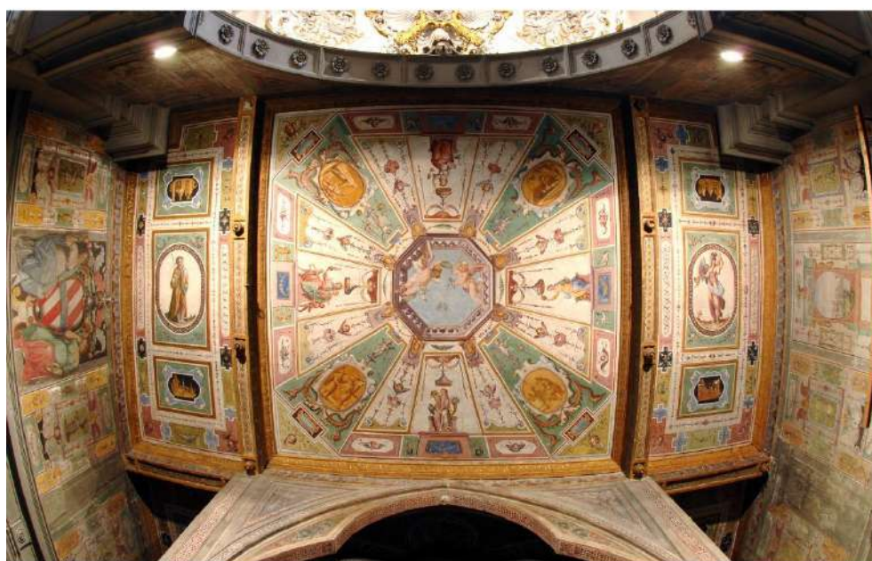
Fig 50 Fotografia della campata centrale prima del crollo. Osservabile la spartizione del soffitto creata con le quattro travi ricalate.
