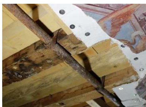
Fig. 53-54 Fotografie della catena visibile dalla lacuna nella parte centrale della decorazione del soffitto
