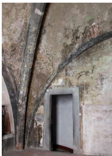
Fig. 98 Infiltrazione del tetto al di sopra del coro.
