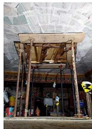
Fig. 101 Puntellatura del perimetro instabile delle lacune.
