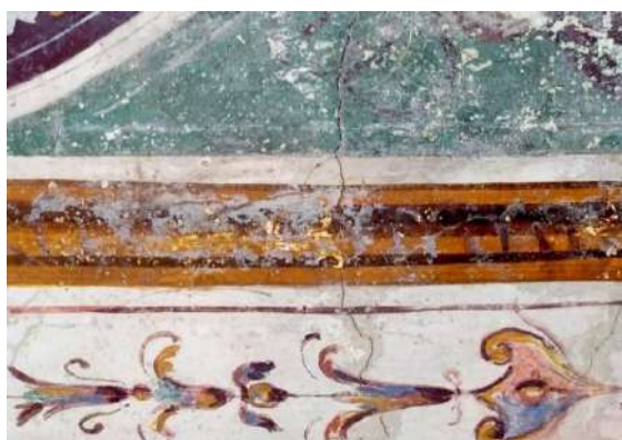
Fig. 129 Residui di ricarbonatazioni.
