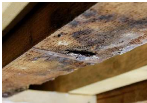
Fig. 56 Chiodi in ferro a testa larga usati per l'ancoraggio del canniccio alle travi
