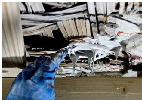
Fig. 161 Applicazione Ledan sul canniccio.
