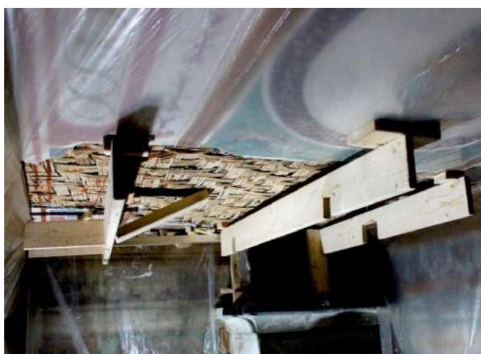
Fig. 158 Struttura di sostegno della lacuna centrale (fotografia in alto).
