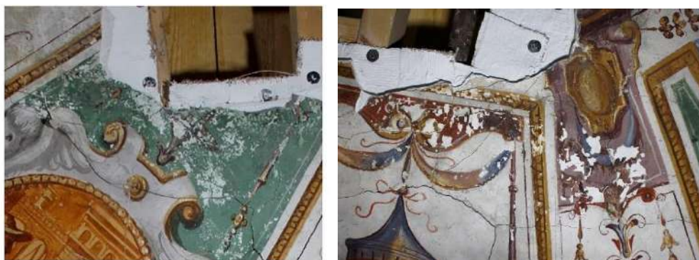
Fig. 104 – 105 Sollevamenti e perdita della pellicola pittorica del perimetro della lacuna centrale.
