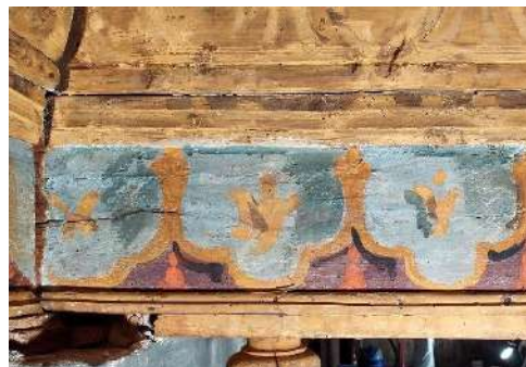
Fig. 188 Ritocco pittorico delle stuccature.
