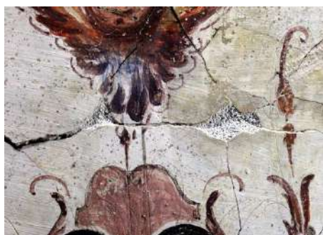
Fig. 132 Reintegrazione con arriccio a base di grassello per le lacune minori
