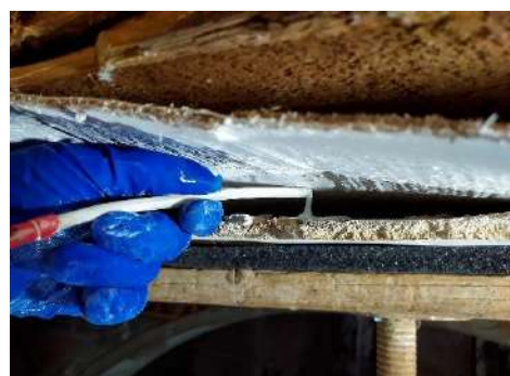
Fig. 119 Iniezione di Ledan GYP nella fessura del distacco.
