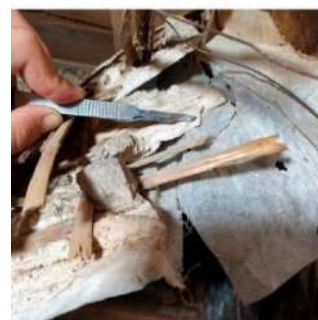
Fig. 57 Fotografia del prelievo di un campione di intonaco per le analisi di caratterizzazione mineralogico petrografica
