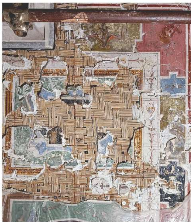
Fig. 164 Riadesione dei frammenti nella lacuna centrale (fotografia in alto).
