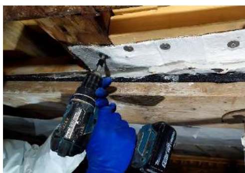
Fig. 120 Fissaggio della tela di juta con viti in acciaio e rondelle ai travetti sani.
