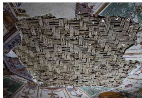
Fig. 136 Applicazione del canniccio nella lacuna centrale.
