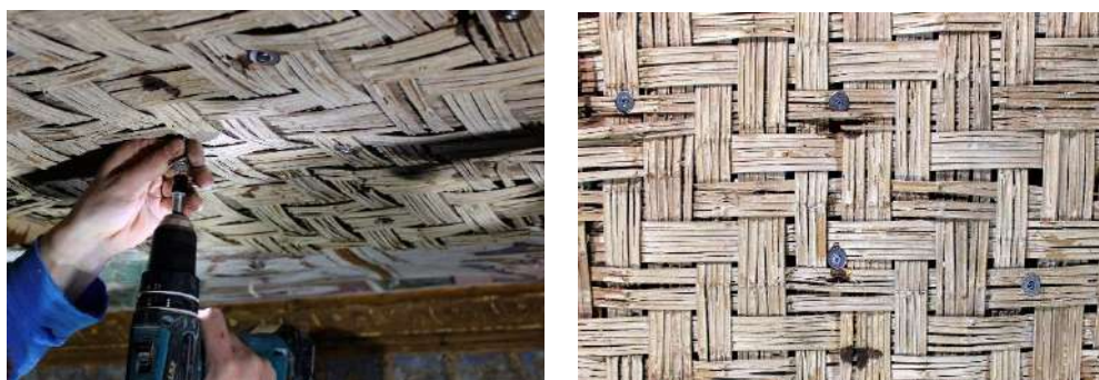
Fig. 137-138 Ancoraggio del canniccio con viti in acciaio inox e rondelle.
