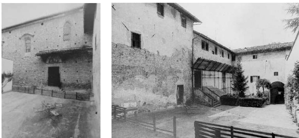
Fig. 10 Fotografie della “piazza” prima che il complesso monumentale andasse in abbandono. Fotografien tratta da Fantozzi, 1996, pp. 86, 90.
