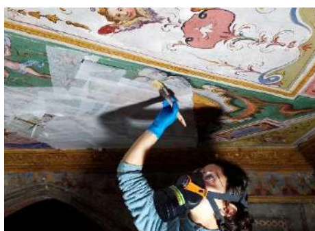
Fig. 122 Applicazione a pennello del solvente puro.
