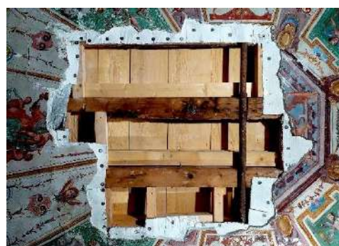
Fig. 121 Perimetro riadeso della lacuna centrale.
