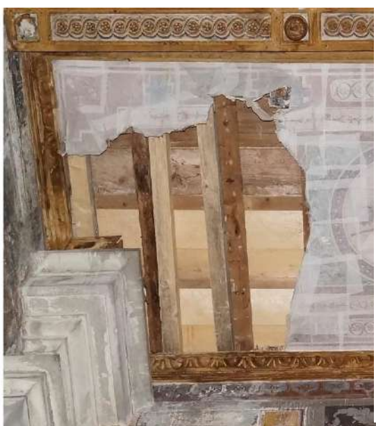
Fig. 51 Fotografia della lacuna laterale (prima del restauro)
