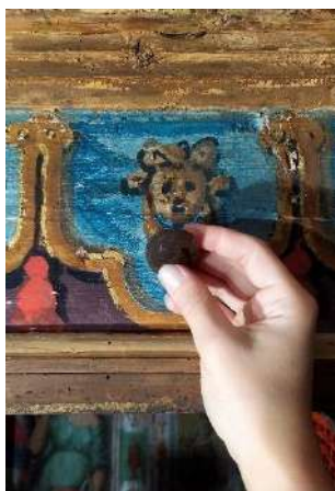
Fig. 186 Pulitura delle travi ricalate decorate con Gel PVA-borace.
