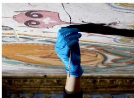
Fig. 130 Inserimento e misura del perno.
