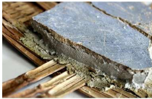
Fig. 152 Prova con malta idraulica della Bio Aedilitia.
