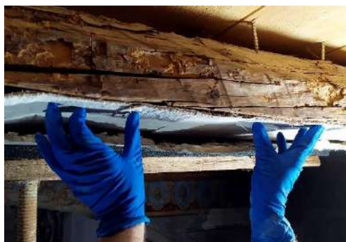
Fig. 118 Inserimento della tela pretrattata tra le travi e il retro dell’intonaco.
