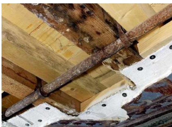
Fig. 98 Infiltrazione del tetto al di sopra del coro.
