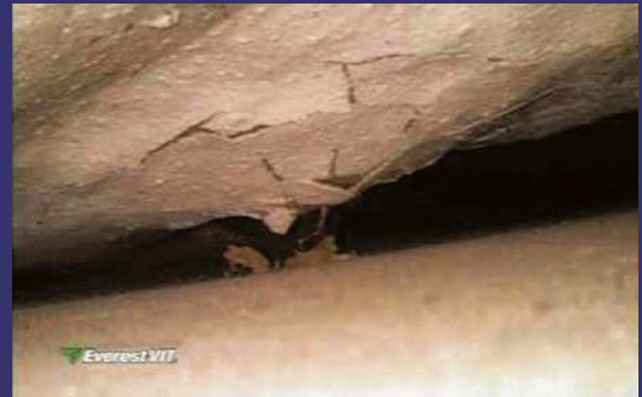
17. Videoendoscopia: cedimento della struttura con frattura del gesso
